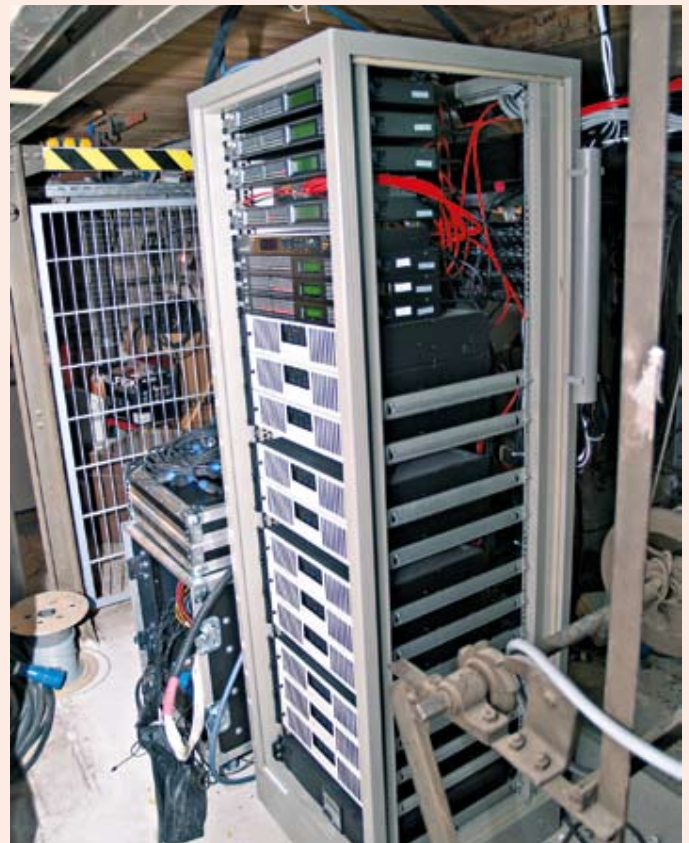
Der sehr kompakte Verstärkerschrank in der Unterbühne
