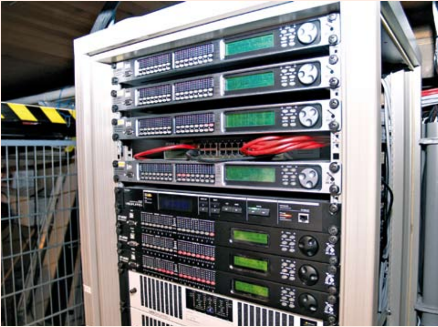
Der Verstärkerschrank enthält (von oben) 4 Stück XD-8080 und 3 Stück XP-8080 Digitalcontroller von Xilica und die Leistungsverstärker der C-Serie von LAB.Gruppen
